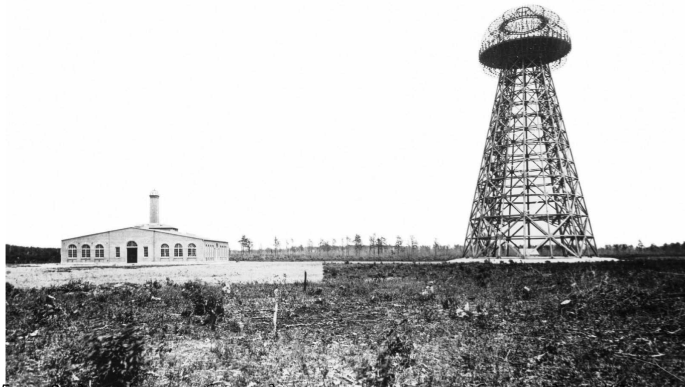
Башня Ворденклиф — первая беспроводная телекоммуникационная башня, созданная Н. Тесла и предназначенная для некоммерческой трансатлантической телефонии, радиовещания, и демонстрации беспроводной передачи электроэнергии.
